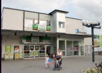
Fruängen Centrum Tukholma Cityconin vuokrattava pinta-ala 14 600 m 2 Rakennusvuosi 1965.
